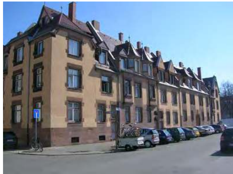
Denkmalgeschützte Wohnanlage Muggenhofer Straße
