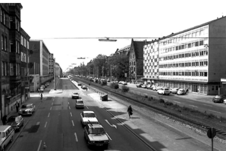
Fürther Straße Höhe Sielstraße 1977
