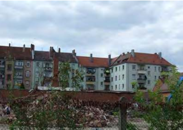
Wohnbereich am Rand der VAG-Brachflächen
