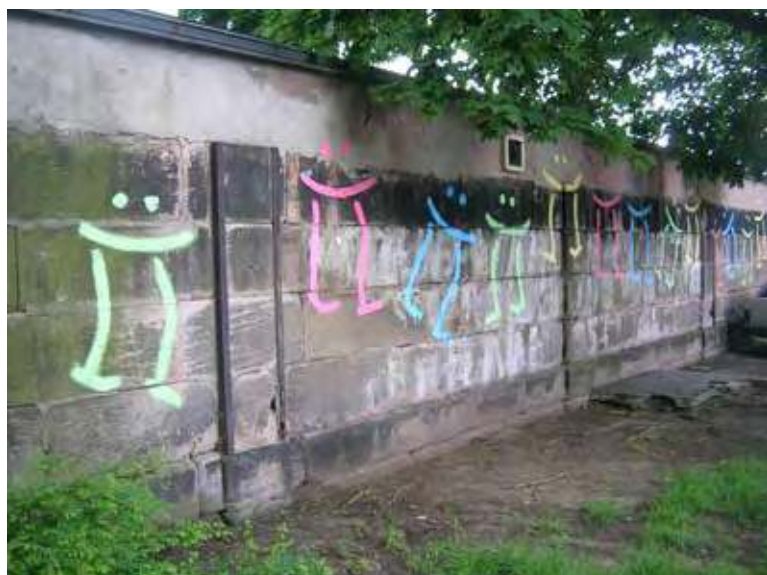
Mauer zum Bahngelände, Austraße
