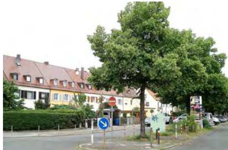
Reihenhäuser in der Leiblstraße
