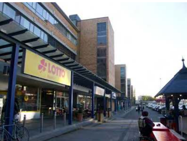
Ladenzelle im ehemaligen Quelle-Gebäude
