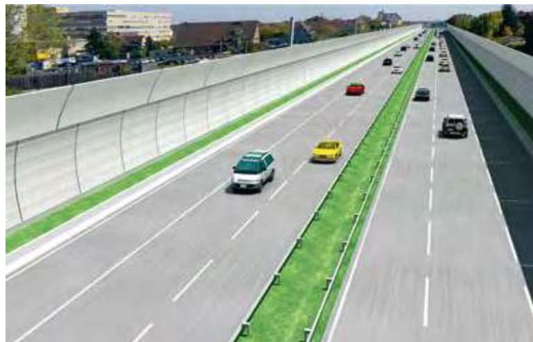
Visualisierung Lärmschutzwand, Quelle: SÖR
