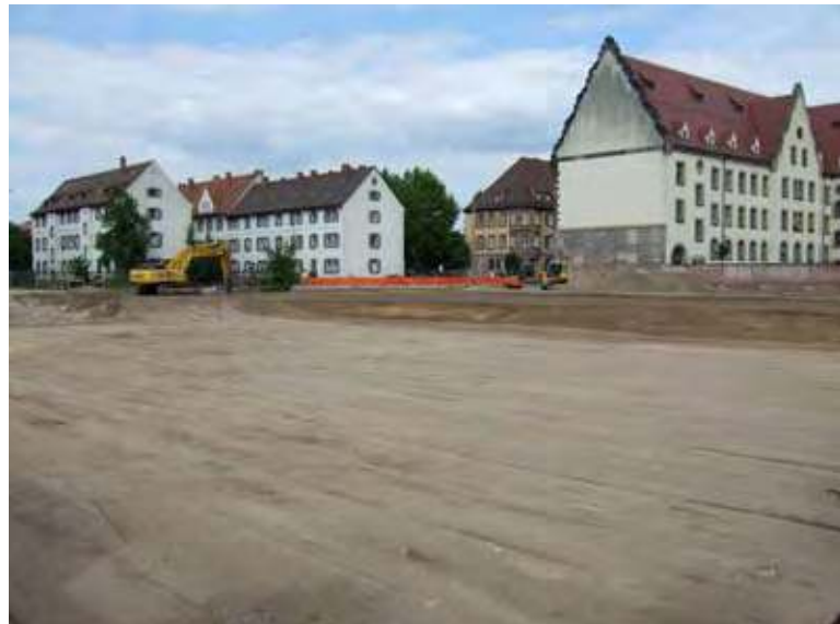
Freigeräumte ehemalige VAG-Flächen
