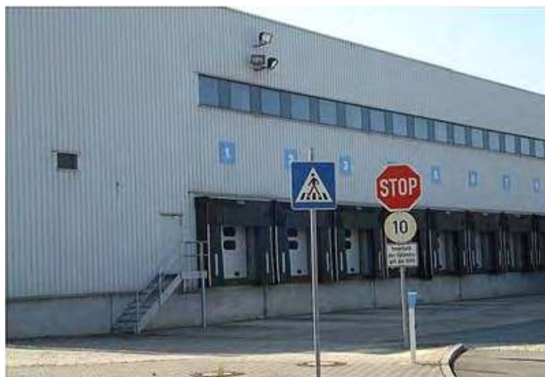
Ehemalige Logistik-Hallen am Bahnhof Doos
