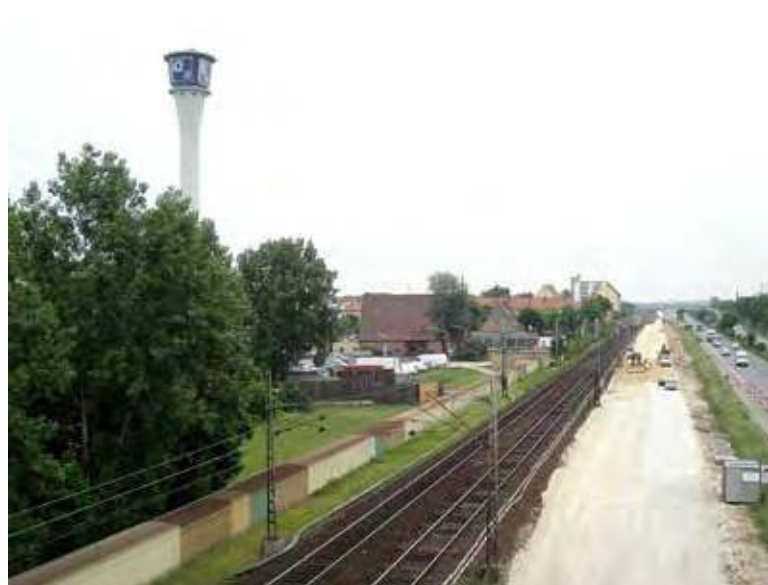
Ausbau Bahnstrecke Nürnberg - Fürth
