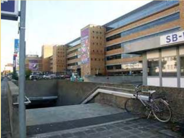
Fassade zur Fürther Straße, U-Bahn Zugang Eberhardshof
