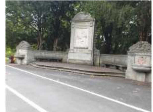
Bestand Schillerdenkmal: gefährliche Wegeführung und unpassende Gestaltung
