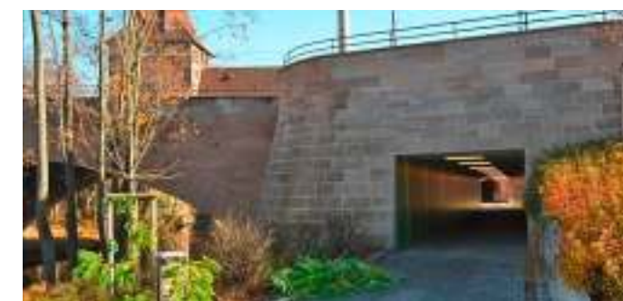
Der Ende 2016 fertiggestellte Durchstich vom Kontumazgarten zur Altstadt hat eine zusätzliche direkte Verbindung für Zufußgehende und Radfahrende geschaffen.
