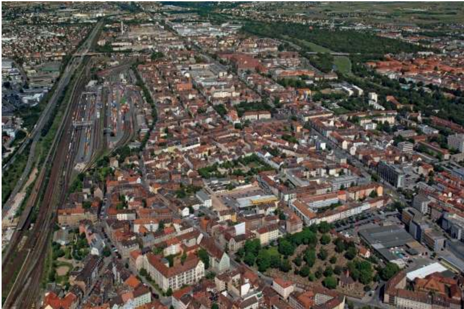
Blick über Gostenhof in Richtung Fürth, im Vordergrund befindet sich der St. Rochusfriedhof Nürnberg Luftbild – Hajo Dietz, Mai 2007
