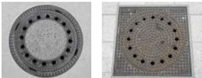
Schachtabdeckung, rund oder eckig, Gusseisen mit Betonguss
