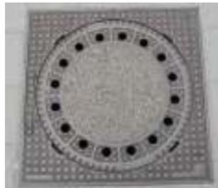
Schachtabdeckung, eckig, Gusseisen mit Betonguss
