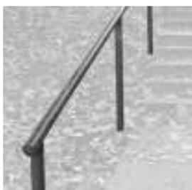
Handlauf aus Stahl, Rundrohr 50 mm
