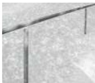
Handlauf aus Stahl, Rundrohr 50 mm, feuerverzinkt
