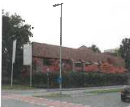
Abb.32: Verwaltungsgebäude der wbg
