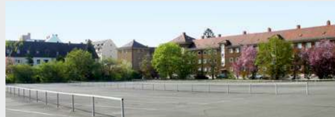
Großflächige Versiegelungsbereiche wie hier auf dem ehemaligen Quelle-Areal begünstigen die Aufheizung des Stadtgebietes.
