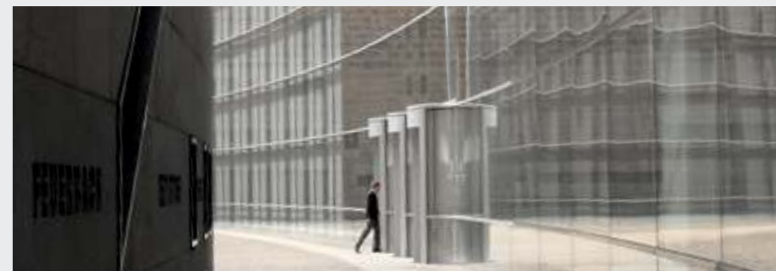
Gebäude mit großen Fensterfronten sind besonders anfällig gegenüber sommerlichen Hitzeperioden.
